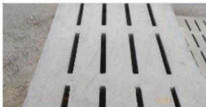
Плита щелевого пола бетонная для сварников 2,0\*0,5\*0,1
